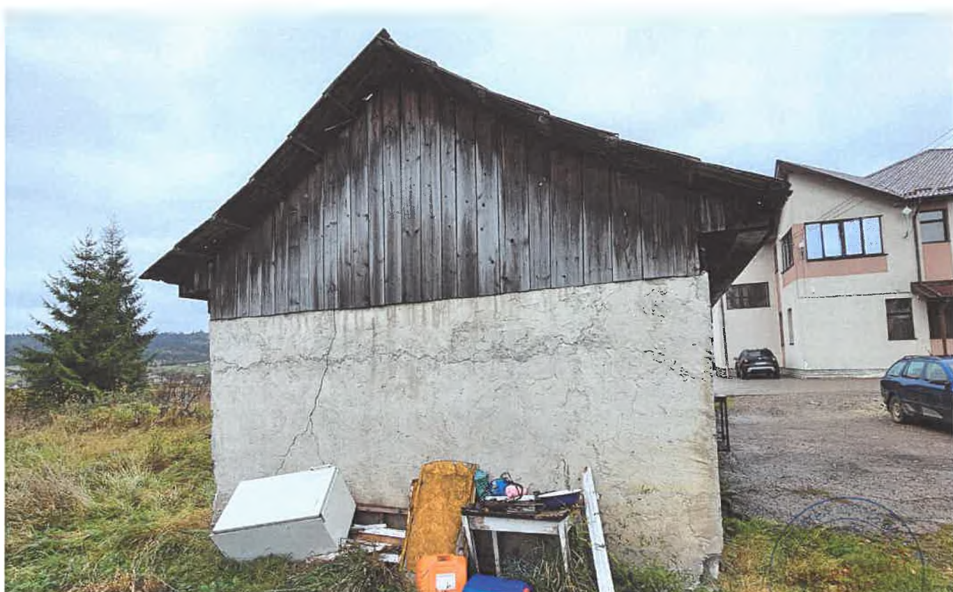
Foto 02 – Aspecte exterioare: vedere de ansamblu fatade
