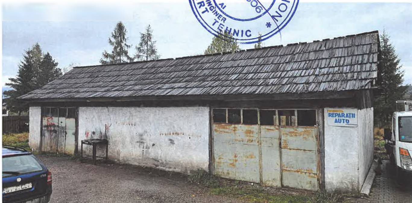
Foto 01 – Aspecte exterioare: vedere de ansamblu fatade
