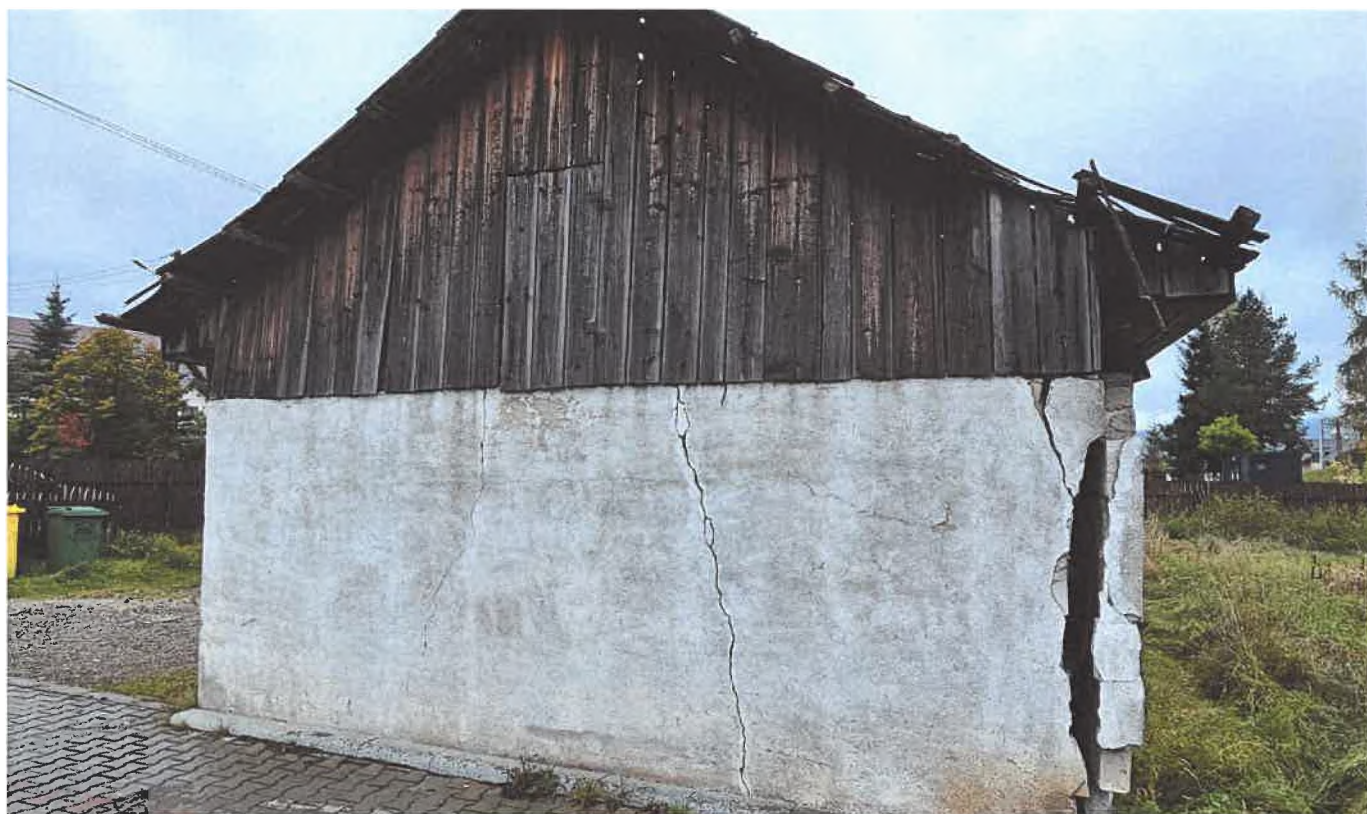
Foto 04 – Aspecte exterioare: vedere de ansamblu fatade
