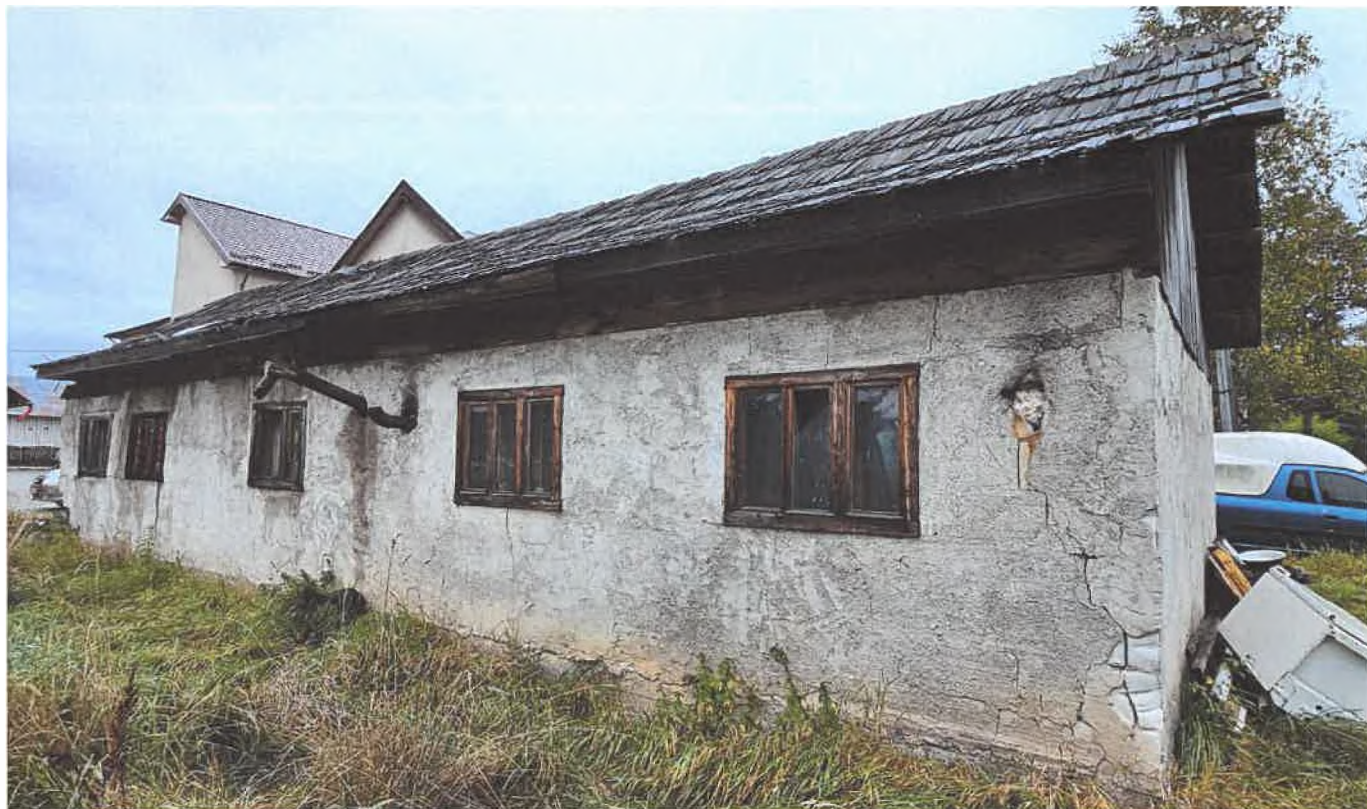
Foto 03 – Aspecte exterioare: vedere de ansamblu fatade
